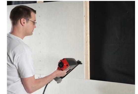
Schnell und einfach zu verarbeiten ist VeroBoard® Classic. Die sonst übliche Fugenarmierung bei Fassadenbekleidungen entfällt.
