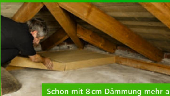
Schon mit 8 cm Dämmung mehr als 80 % U-Wert-Verbesserung möglich
