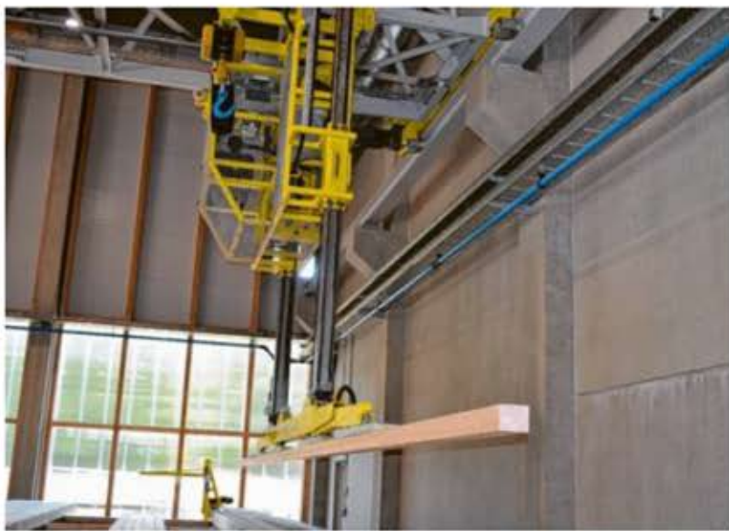
Ein vollautomatischer Kran hievt am neuen Standort einen Holzbalken in die Produktionsstraße. Foto: Ralf Gengnagel
