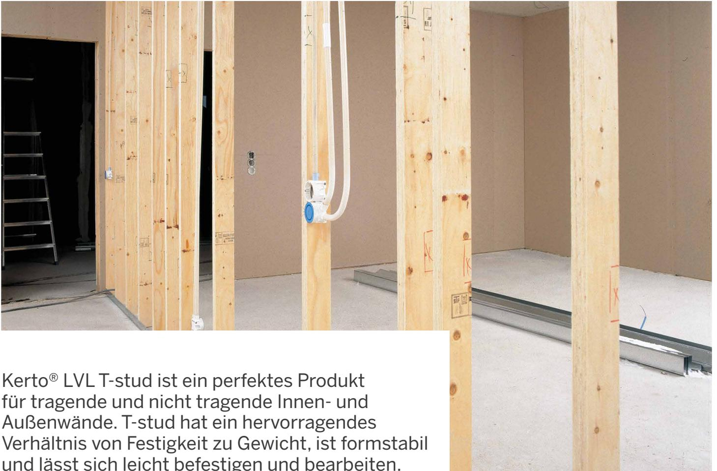
Kerto® LVL T-stud ist ein perfektes Produkt für tragende und nicht tragende Innen- und Außenwände. T-stud hat ein hervorragendes Verhältnis von Festigkeit zu Gewicht, ist formstabil und lässt sich leicht befestigen und bearbeiten.
