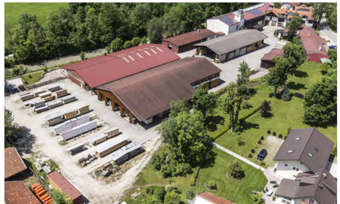
Ruhpolding • Firmensitz • 13.500 m 2 Lagerfläche
