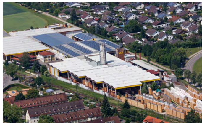
Dillingen a.d. Donau • Hobelwerk • 43.000 m 2 Lagerfläche
