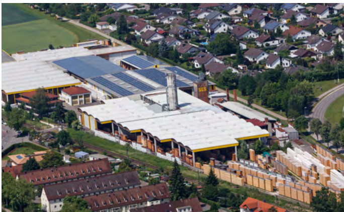
Dillingen a. d. Donau • Hobelwerk • 43.000 m² Lagerfläche
