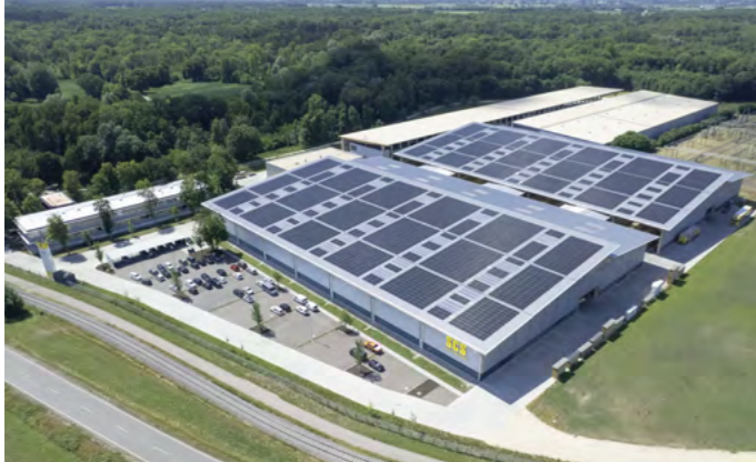
Gundremmingen • Unternehmenszentrale • 40.000 m 2 Lagerfläche, davon 10.000 m 2 komplett UV-geschützt
